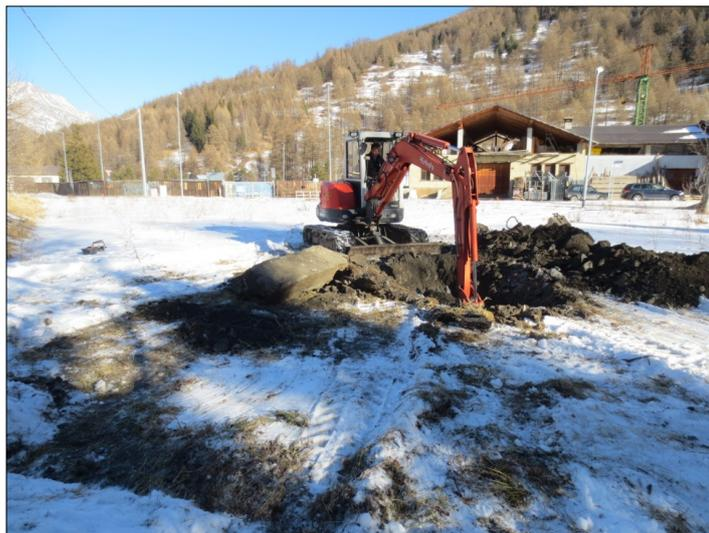
*<<<Per approfondirsi nel terreno ghiacciato si è reso necessario una predemolizione con martello demolitore*
