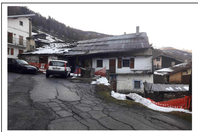
Edificio oggetto di demolizione (prospetto ovest)
