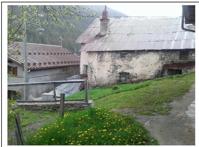
Edificio oggetto di demolizione (prospetto est)
