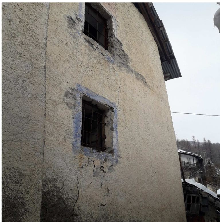
Particolare del prospetto sud
