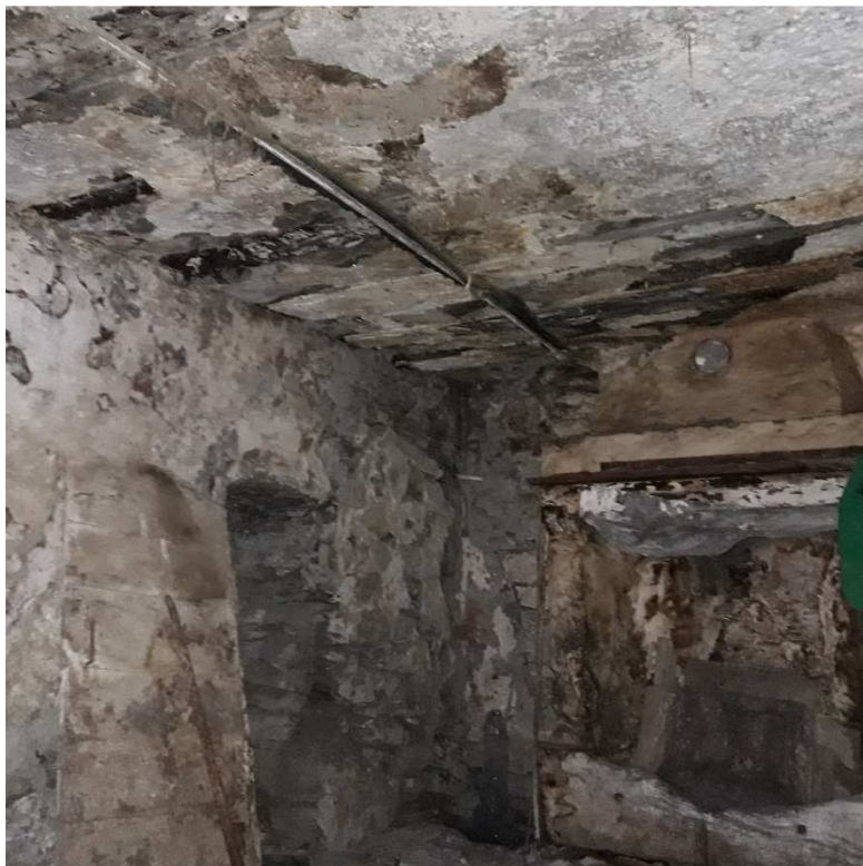
Solaio in travetti di legno e tamponamenti in pietra
