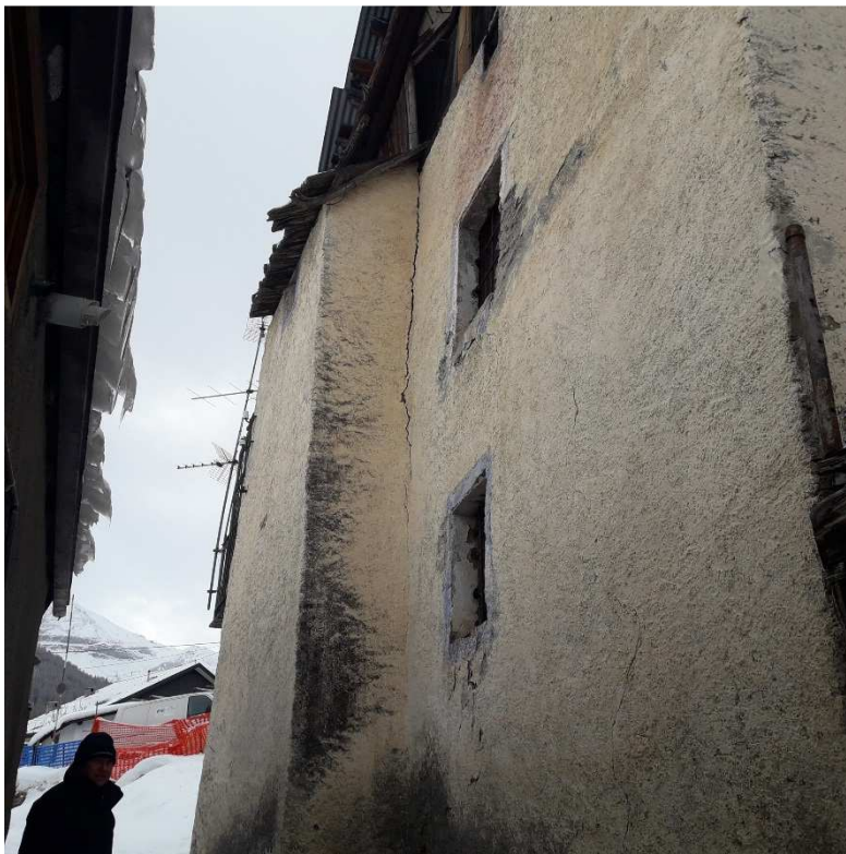
Particolare del prospetto sud
