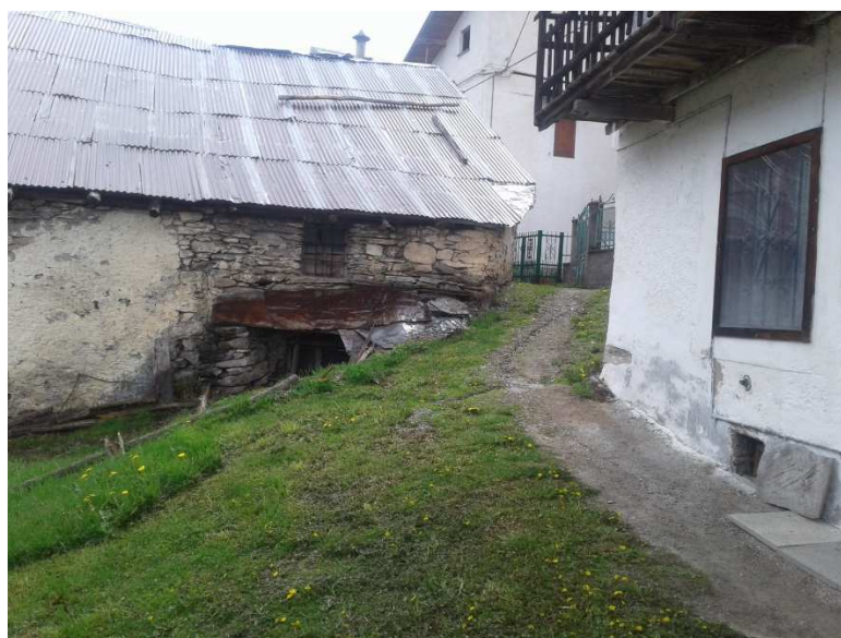
Il fabbricato verso Via Allevè
