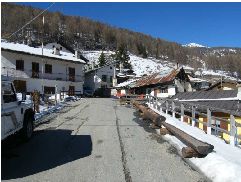
Il fabbricato oggetto di smontaggio visto da Via degli Alpini
